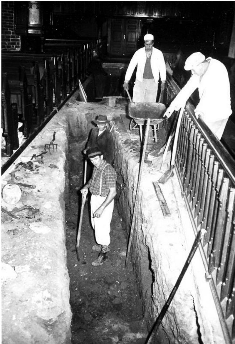
Dieses Bild (ca. 1960) gibt uns einen Einblick in den Einbau der Heizung. Sie wurde in den ehemaligen Eingängen der Tunnel zwischen Kirche und Kloster installiert. Die Tunnel sind ansonsten nicht mehr erhalten. Wenn Ihnen in der Kirche einmal kalt sein sollte: Warme Luft kommt aus den Gittern vor der Kanzel und am Altar.
